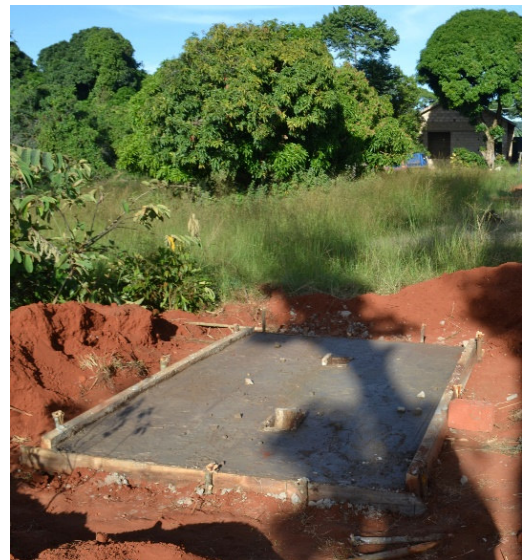
Betonfundament über der Toiletten-Grube
